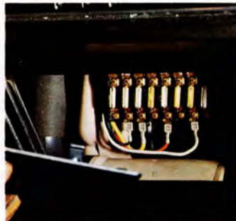
Säkringarna lätt åtkomliga under instrumentpanelen
