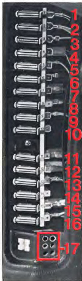
17 Hal för reservsäkringar
